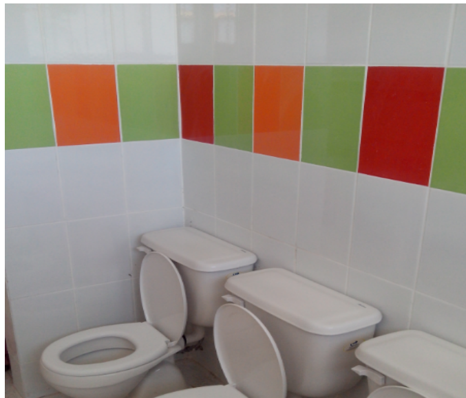
A) Instalación de Palmetas de color en Muro
