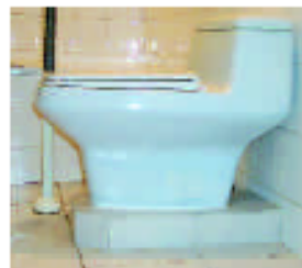
Altura WC modificada en obra para alcanzar la altura adecuada.
