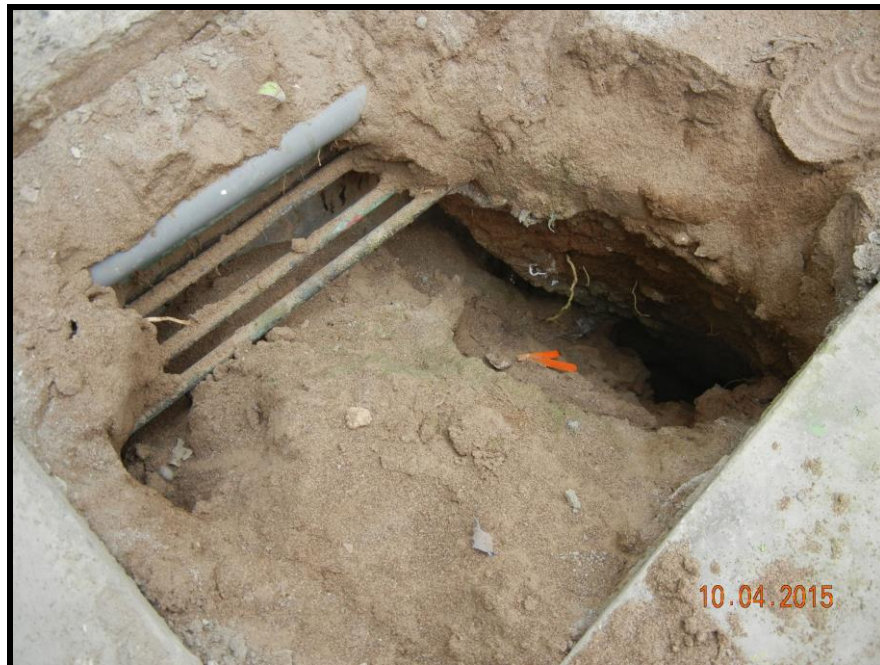
Socavón del terreno
