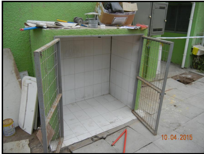
Estado actual caseta del gas.
