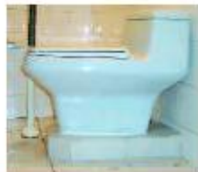
Altura WC modificada en obra para alcanzar la altura adecuada.
