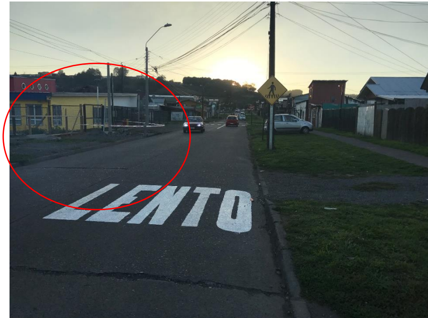
Figura N°3: Imagen tomada en calle Temuco desde Iquique hacia Antofagasta, muestra acceso N°2 y señalética existente en el lugar.
