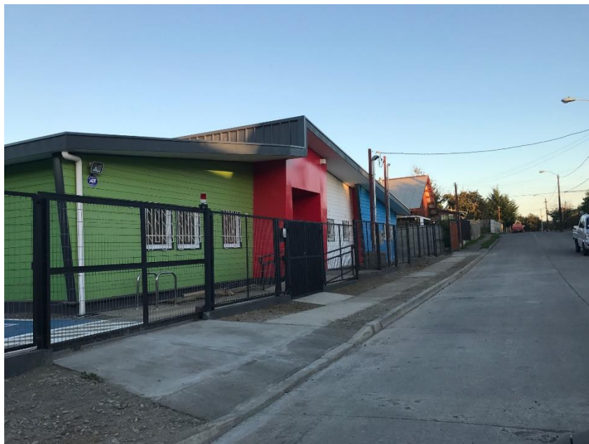
Figura N°3: Imagen tomada en calle Tres sur desde Acapulco hacia Dos poniente muestra acceso estacionamiento de Discapacitados
