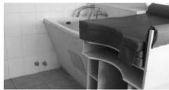
**BARRA SUJECION ;** Se debera instalar una barra de seguridad de acero inoxidable, en el muro que esta por sobre la tineta para que el nino(a) se sujete mientras se desarrolla el proceso de aseo e higiene.
