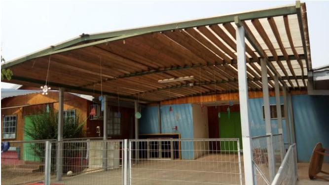
Su instalación se realizará según indicaciones del fabricante, en cuanto a traslapos y medio de afianzamiento a la estructura metálica existe.
