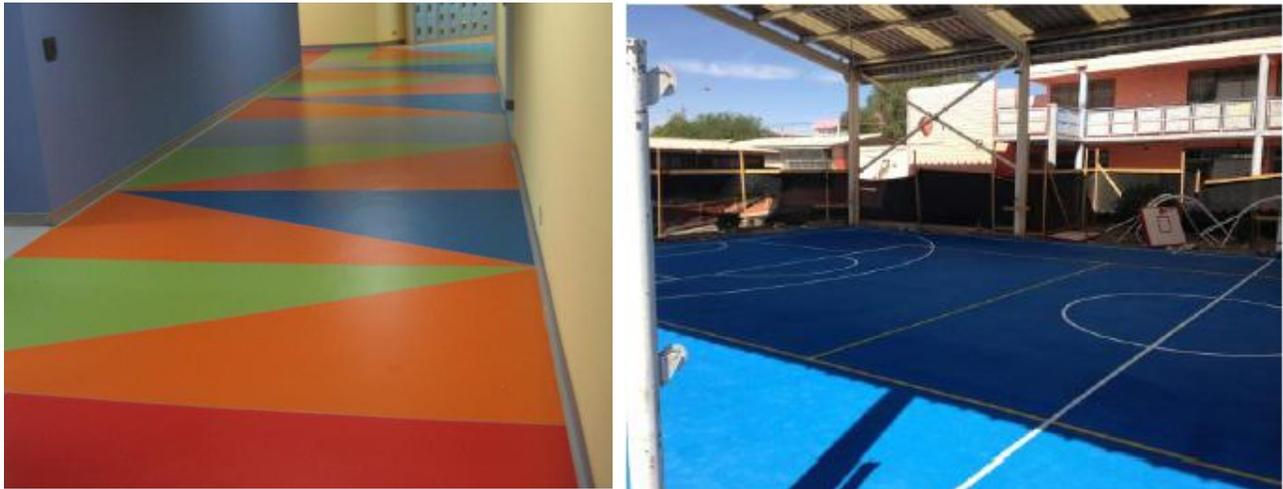
Consiste en una carpeta multicapas de 13mm de espesor de base de caucho granulada, aplicación de resinas, aglutinantes poliuretánicas, sellos, auto nivelantes y recubrimiento de pintura de poliuretano como terminación, ubicada según planos de arquitectura e instaladas según EETT del fabricante. Se adjunta Ficha Técnica. El diseño será de acuerdo planimetría, y los colores se definirán por el ITO.
