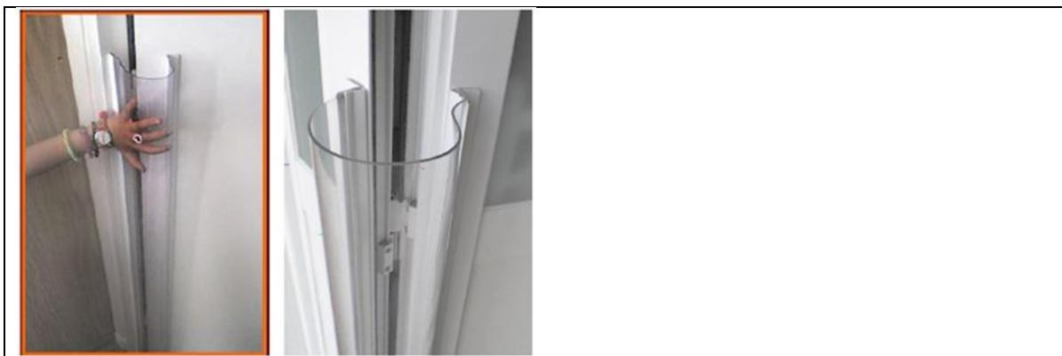
Se instalarán, en cada extremo del PVC flexible, dos perfiles L de aluminio blanco 20x20 mm, uno sobre el otro, y con el PVC en medio. El aluminio irá atollado a la puerta-marco, y se emplearán remaches para sujetar el PVC flexible al sándwich de perfiles de aluminio.
