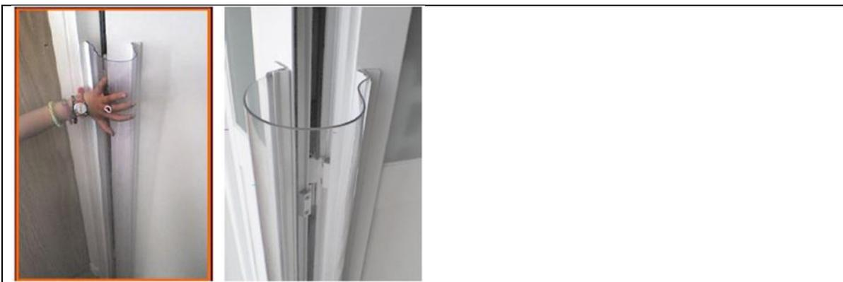
Se instalarán, en cada extremo del PVC flexible, dos perfiles L de aluminio blanco 20x20 mm, uno sobre el otro, y con el PCV en medio. El aluminio irá atollado a la puerta-marco, y se emplearán
