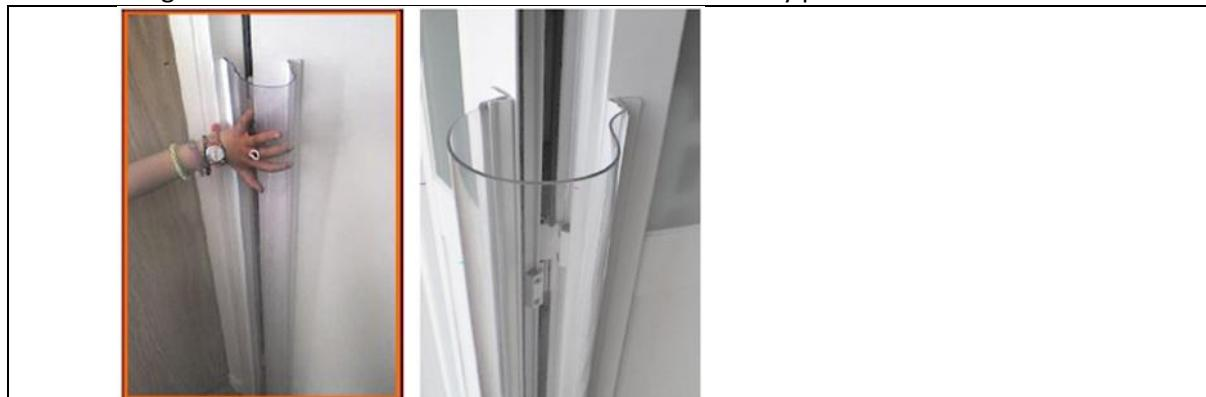
Se instalarán, en cada extremo del PVC flexible, dos perfiles L de aluminio blanco 20x20 mm, uno sobre el otro, y con el PCV en medio. El aluminio irá atollado a la puerta-marco, y se emplearán remaches para sujetar el PVC flexible al sándwich de perfiles de aluminio.
