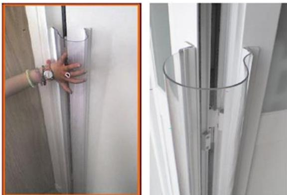
Se instalarán, en cada extremo del PVC flexible, dos perfiles L de aluminio blanco 20x20 mm, uno sobre el otro, y con el PVC en medio. El aluminio irá atollado a la puerta-marco, y se emplearán remaches para sujetar el PVC flexible al sándwich de perfiles de aluminio.
