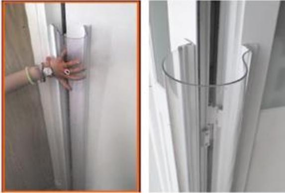
Se instalarán, en cada extremo del PVC flexible, dos perfiles L de aluminio blanco 20x20 mm, uno sobre el otro, y con el PCV en medio. El aluminio irá atollado a la puerta-marco, y se emplearán remaches para sujetar el PVC flexible al sándwich de perfiles de aluminio.
