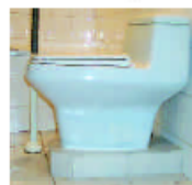
Altura WC modificada en obra para alcanzar la altura adecuada.
