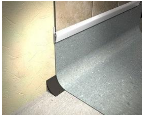
Imagen n°4. Instalación de retorno piso vinílico rollo.
